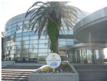
サッポロビール千葉工場
